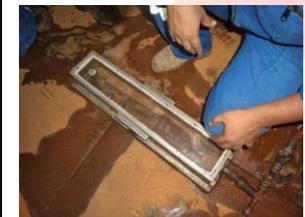
**INSPECCIONES POR CAJA DE VACÍO.**
